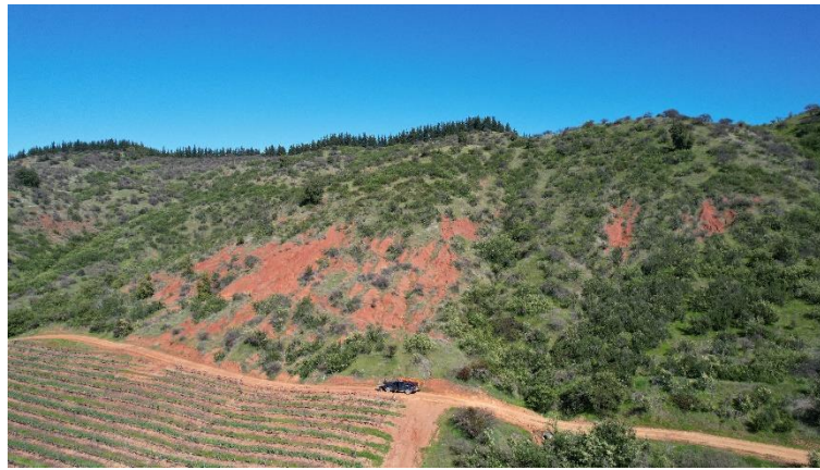
Mantenimiento camino contorno a bosque nativo, Fundo Palo Santo (agosto 2026)
