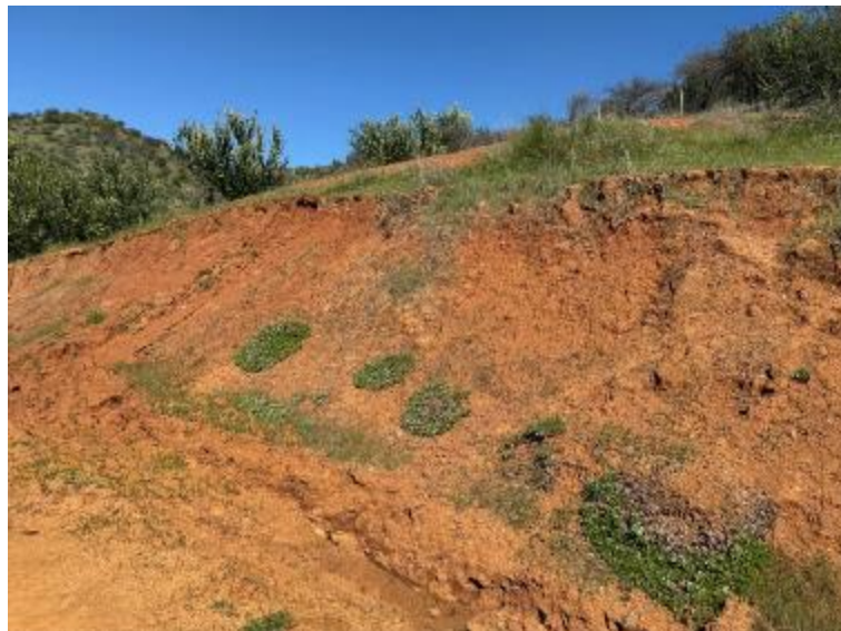
Evidencia detección de erosión camino contorno a bosque nativo, Fundo Palo Santo (septiembre 2025, antes de la mantención)
